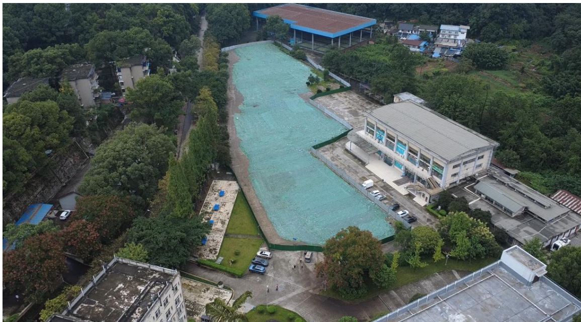
图 1.4-2 主体工程占地区域现状照片(备注：拍摄时间为 2025 年 9 月)
